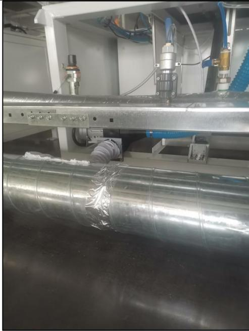
图 3-5 熔焊废气收集管道
