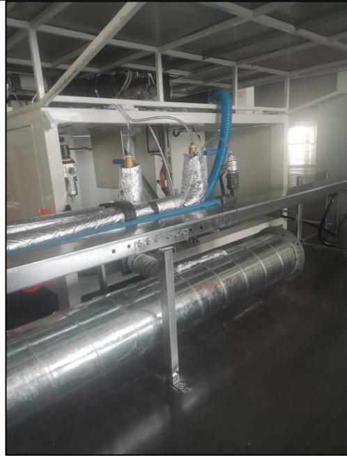
图 3-6 熔焊废气收集管道
