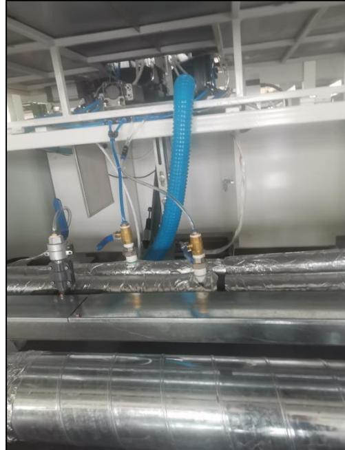
图 3-4 熔焊废气收集管道
